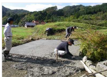
地域住民による直営施工 (農道舗装)
