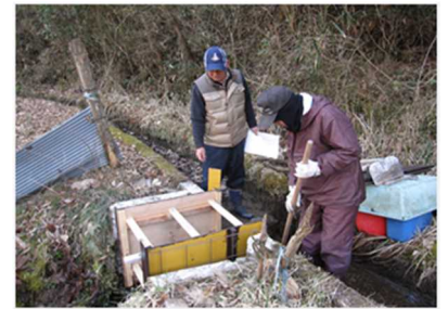
直営による水路の補修
